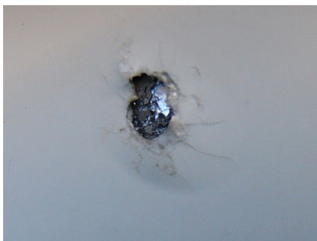
図 2 - 5 パネル裏面の破損 2 (ND-L3EJE)
