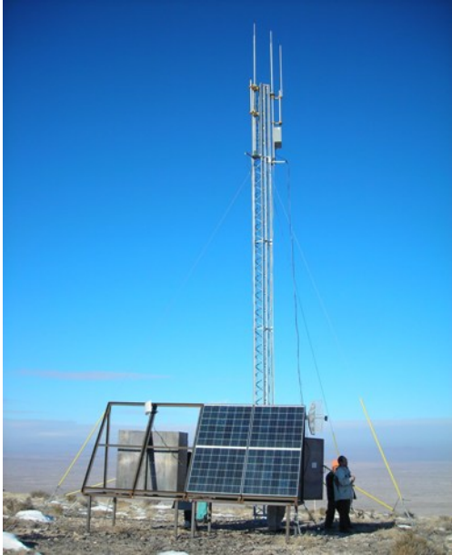
図 4.6 通信塔。ソーラーパネルにより電源供給している。
