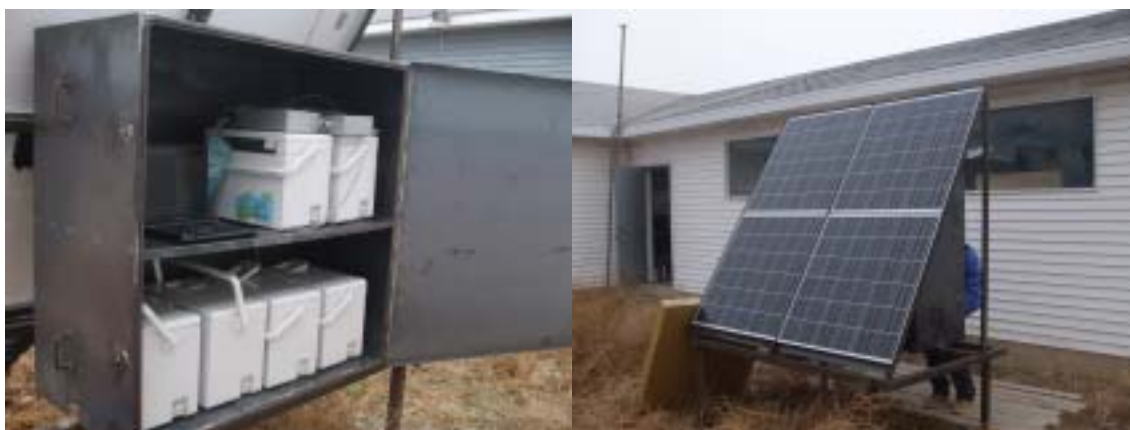
図 2-3-5 1BOX の写真(パネル 4 枚、バッテリー 6 個)
