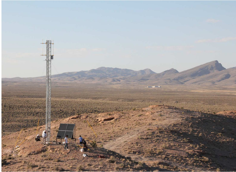
図 2.9: TALE 実験用の無線 LAN 通信塔. 太陽電池パネルにより電源供給している. 写真の右奥には MD/TALE-FD ステーションが小さく写っている.
