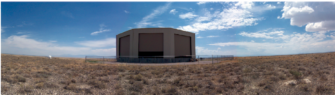
図 3.3: FD ステーション (Black Rock Mesa サイト) の外観
